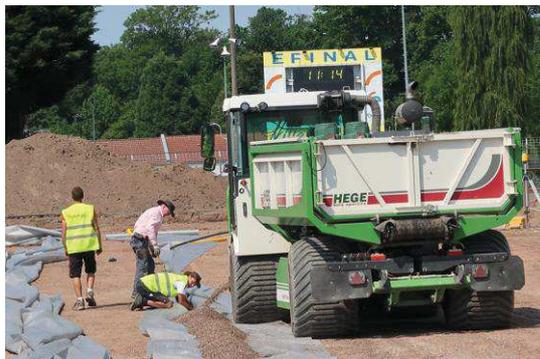
Le terrain a été entièrement décaissé. Grâce à un véhicule ingénieux, le drainage est déversé sur les gaines du futur système d'arrosage intégré.
