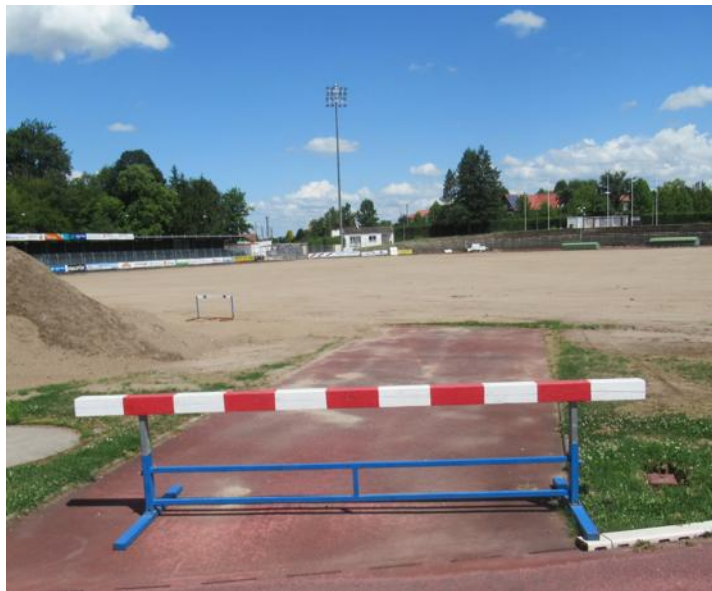
Le chantier du stade a débuté le 19 juin dernier. Il a pour but de changer la piste d'athlétisme mais également la pelouse. Photo Ph.N.
